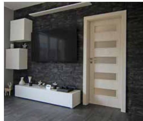
obklad kovové zárubně s novými dveřmi
